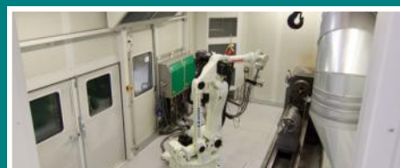
Cabina di rivestimento
