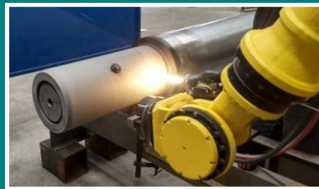
Rivestimento Thermal Wire Spray
