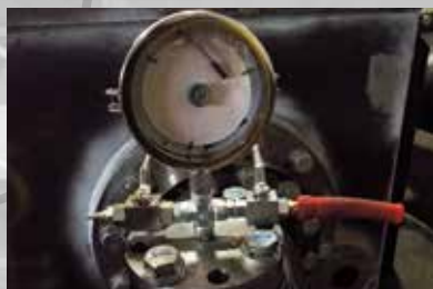
Prova di pressione Pressure test
